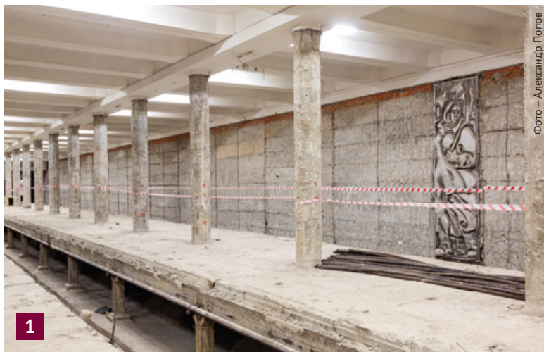
На «Каховской» завершён демонтаж облицовки (1) Отсечные ворота в конце тупиков (2)
